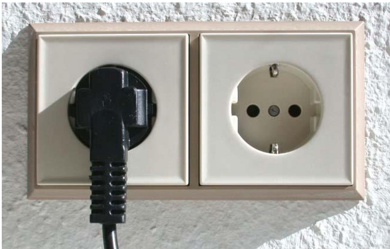
Розетки типа Schuko, в одну из них вставлена вилка шнура сетевого **ШС 0502**.
